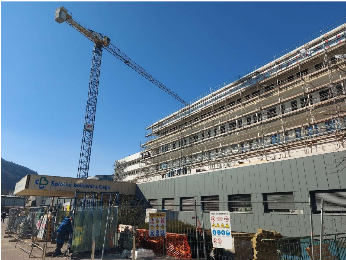
Slika 3: Stanje na gradbišču Energetske sanacije (februar 2021)
