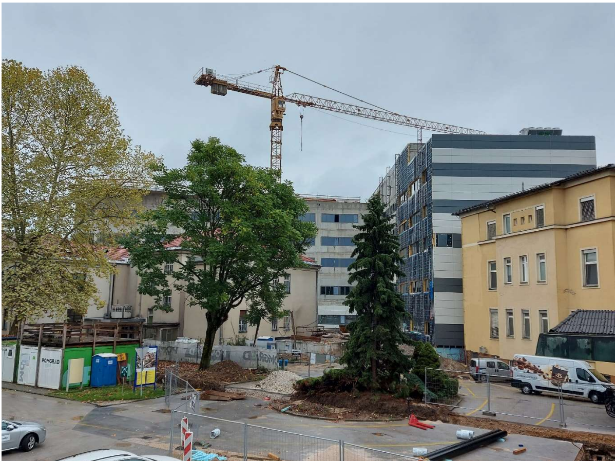
Slika 2: Stanje na gradbišču Etape 1 v oktobru 2021 (Dokončana nadzidava in dozidava konstrukcije k UCC, polaga se fasada, gradi se heliport ...)
